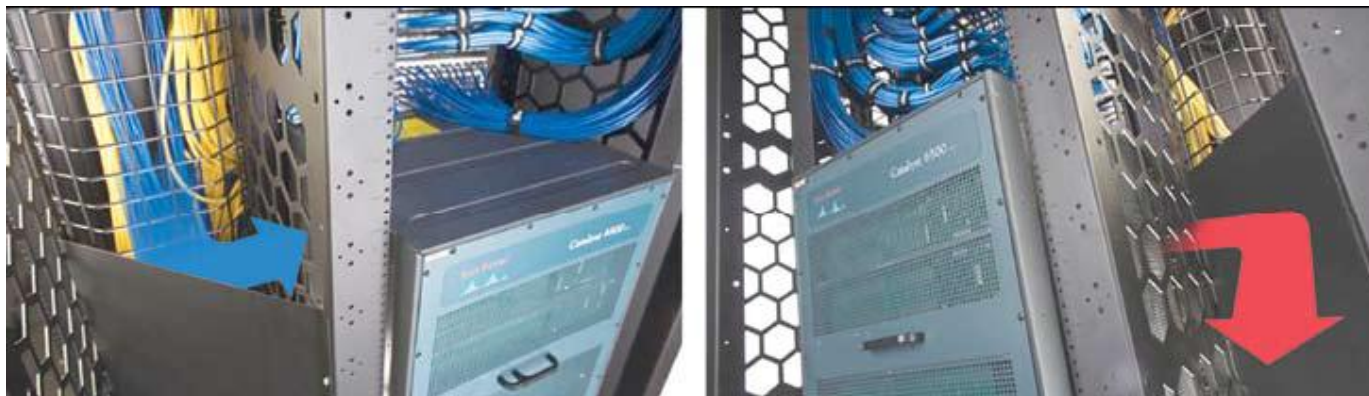
Рисунок 3 Дефлекторы и перфорация могут обеспечить поток воздуха спереди назад в стойках, содержащих оборудование, вентилируемое с боков.
